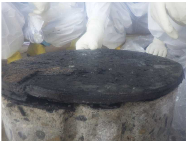
2号機原子炉建屋 天井から抜いたコア
