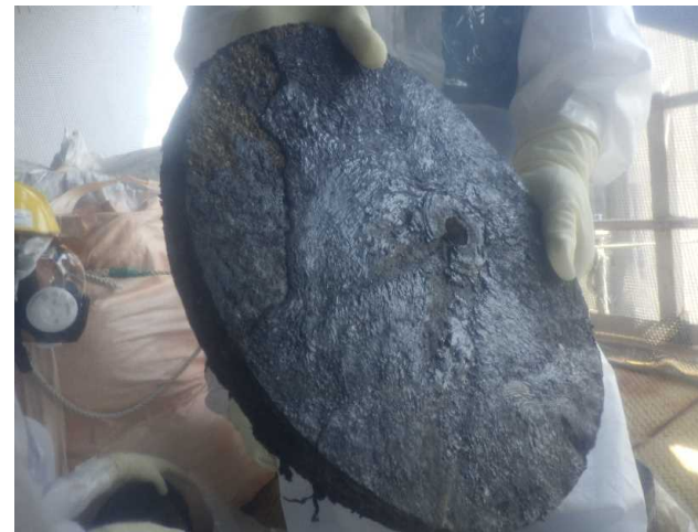
コンクリートコア の防水層
