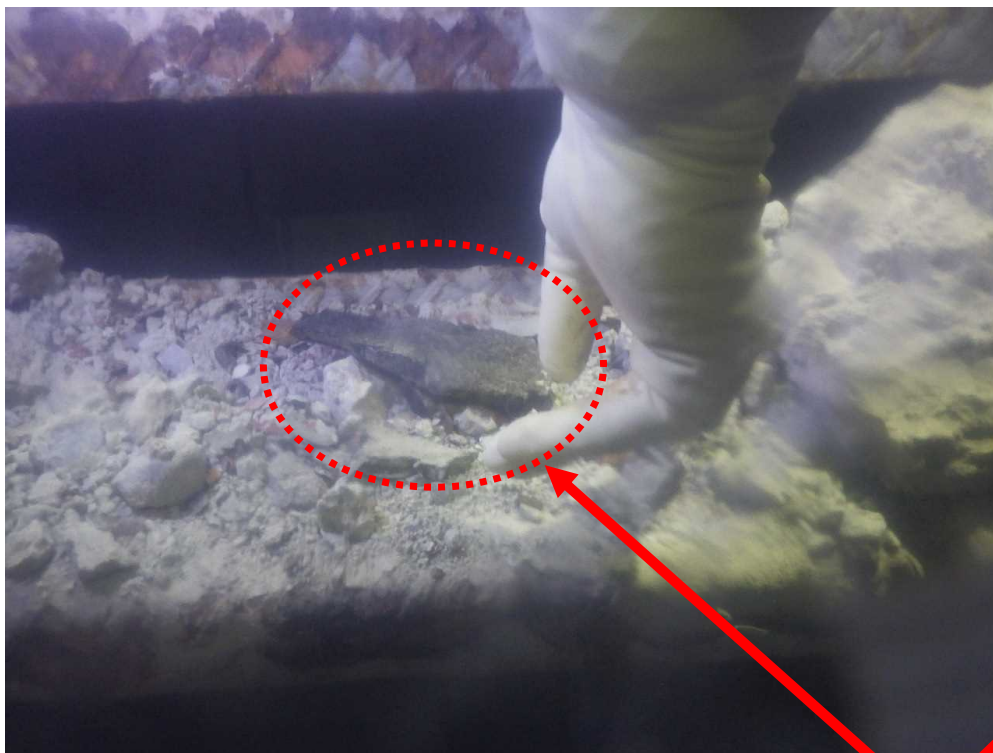
アスファルト防水層の 破片と思われる物質
