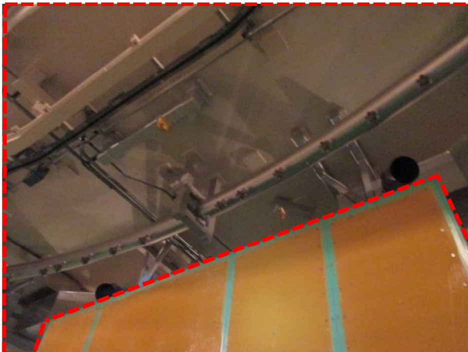
格納容器上部に火災防護対象機器等が設置されていないことを確認
