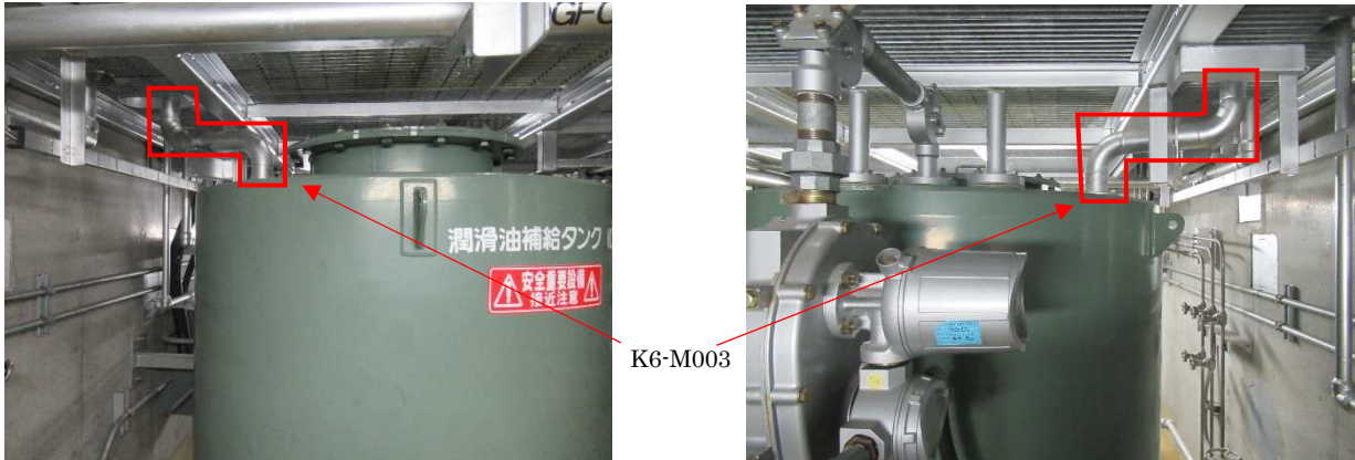
図 1-3 現場状況写真（潤滑油補給タンク周辺）
