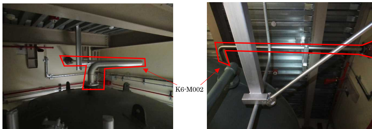
図 1-2 現場状況写真（燃料ディタンク周辺）
