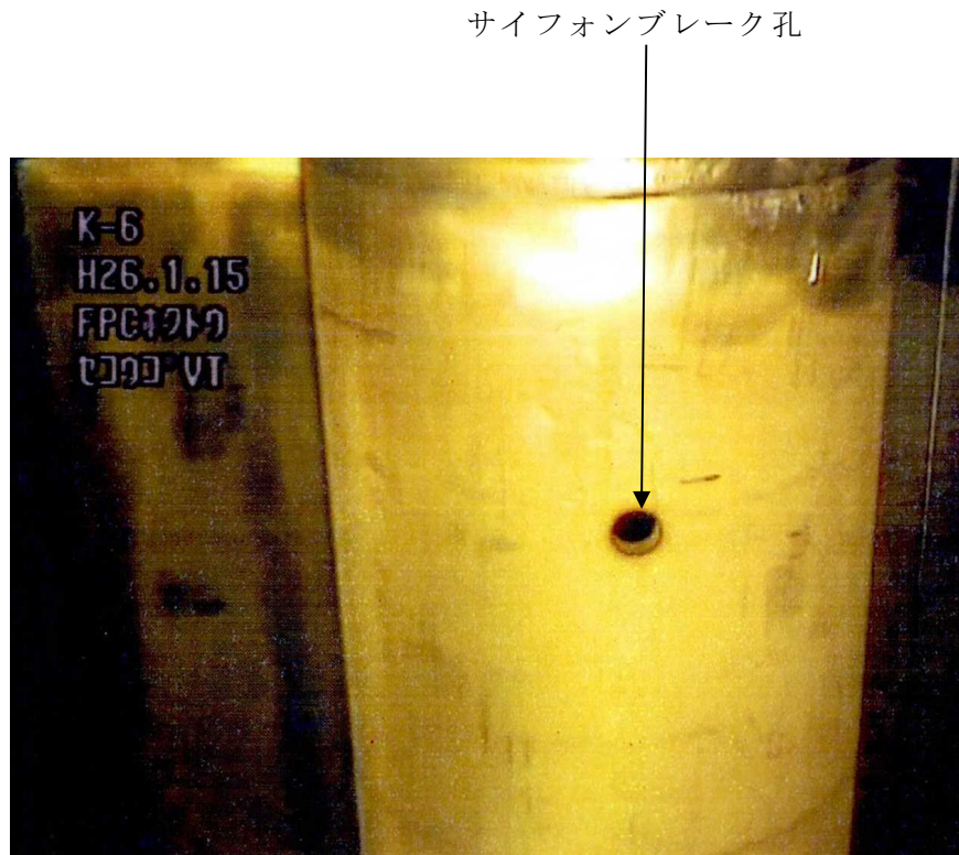
図 1-2 サイフォンブレイク孔の現場写真
