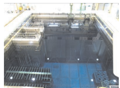
使用済燃料貯蔵プール全体
