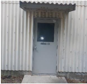
6号倉庫 (南西出入口)
