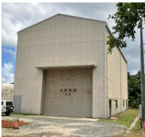
6号倉庫 (西側シャッター前)
