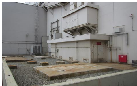
撤去作業後の状況
