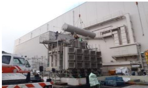
撤去作業の状況
