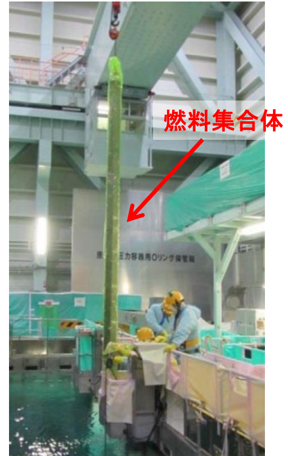
新燃料の引き上げ状況
