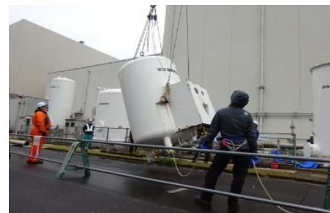
撤去作業の状況
