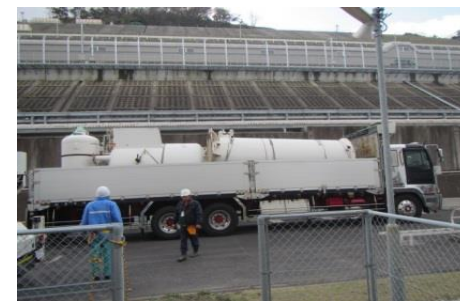
解体物の移送
