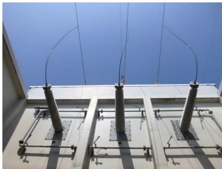
154kV荒浜線引込部（イメージ）
