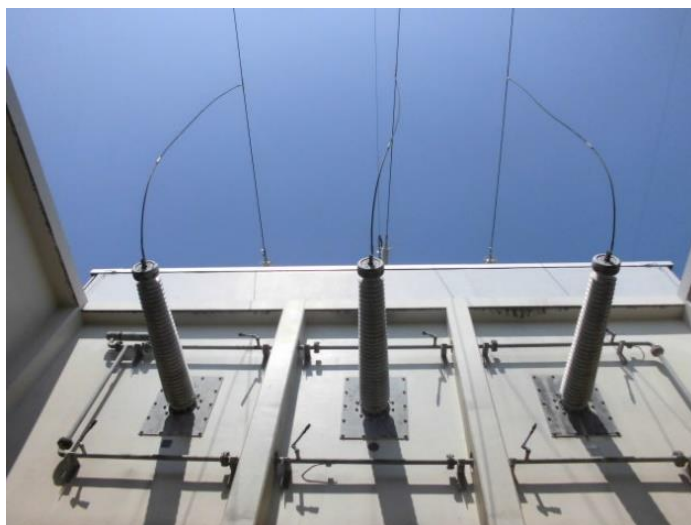
(154kV開閉所 送電線引込部イメージ)
