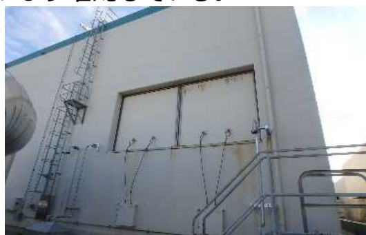
燃料取替床ブローアウトパネル（施工前）
