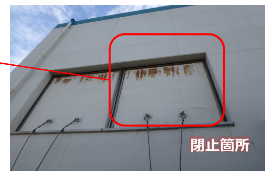
燃料取替床ブローアウトパネル閉止装置 （待機状態，取付前）
