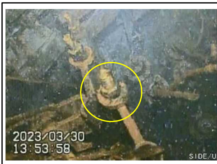
写真1. CRDサポートロッドの状況
