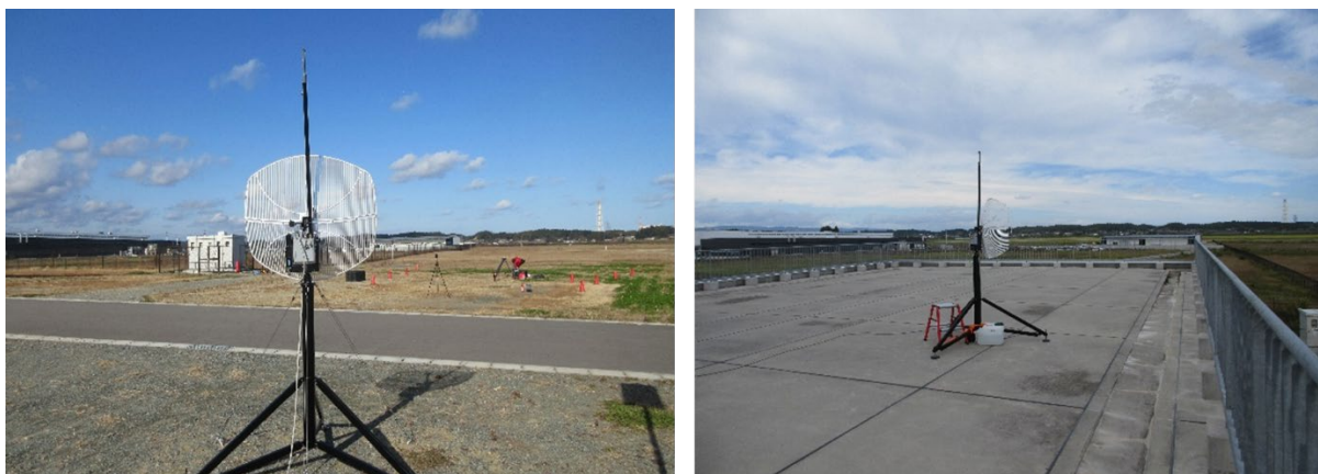
Fig. 6-10 通信試験アンテナ設置状況
