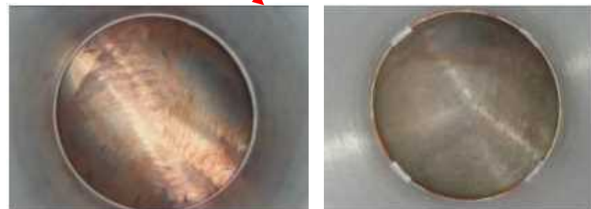
③・④の例：検査孔からのホットレグ内管の外観確認結果
