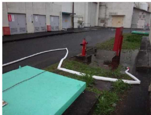
消火用ホース
