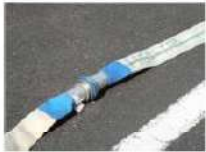
④ 可搬型ホース接続後
