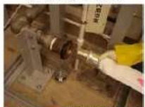
⑤ 可搬型ホースへ使用済燃料ピット補給用冷却配管 接続前
