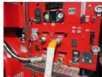
② ポンプ車へ吐出ホース接続後
