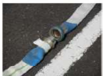
③ 可搬型ホース接続前
