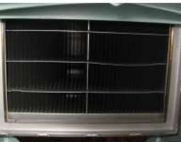
装置底部 (PAR入口給気口)
