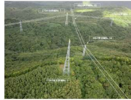
第2.2.3.5図 ③交差箇所の現地状況 (1/3)
