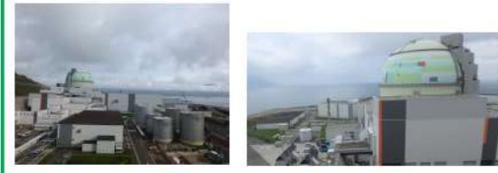
2号炉タービン建屋屋上
