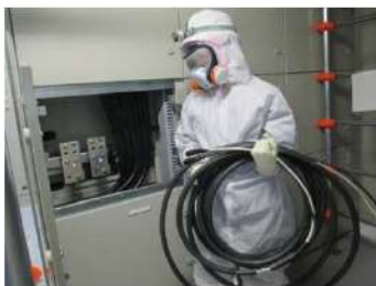
可搬型直流変換器 直流出力ケーブル敷設作業 (安全補機開閉器室) (原子炉補助建屋T. P. 10. 3m)
