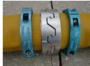
可搬型ホース（150A）接続後
