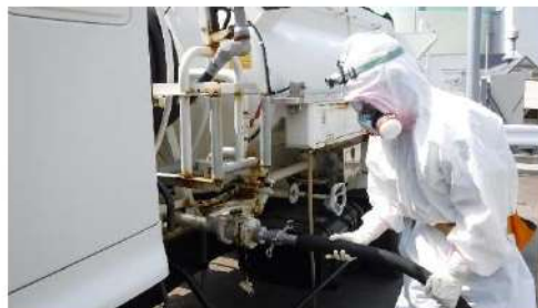
可搬型タンクローリーへのホース接続(継手接続式) (屋外)
