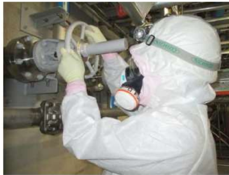
原水槽から補助給水ピットへの補給 系統構成 (周辺補機棟 T.P. 17.8m)
