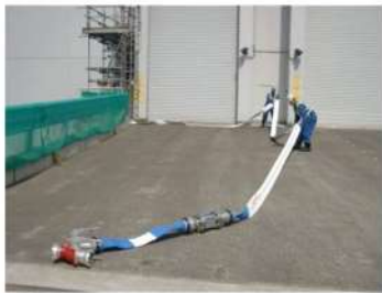
可搬型ホース敷設 （屋外）
