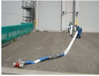
可搬型ホース敷設 (屋外)
