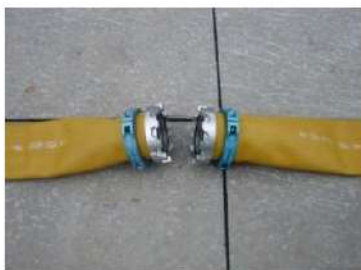
可搬型ホース(150A)接続前
