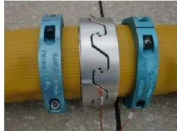
可搬型ホース(150A)接続後
