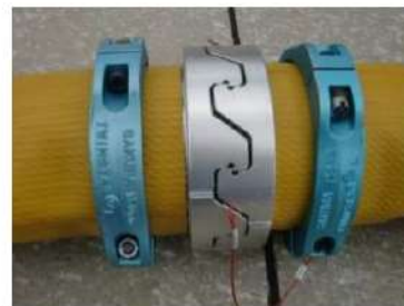
可搬型ホース(150A) 接続後
