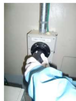
電源ケーブル接続
