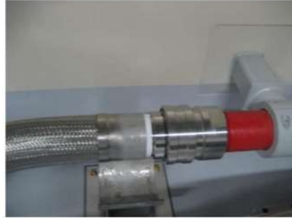
消火水系配管と 格納容器スプレイ系配管との 接続のための可搬型ホース接続後 (運転員(現場) B) (原子炉補助建屋 T. P. 10. 3m)
