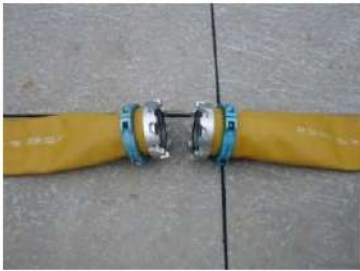
可搬型ホース(150A)接続前
