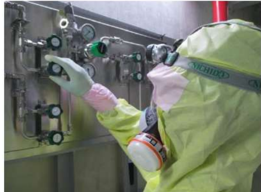
代替空気(窒素)供給操作 (周辺補機棟 T. P. 24. 8m)
