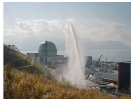
第10図 直状放射による放水状況
