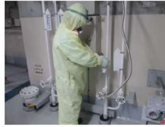
(制御用空気供給弁閉操作イメージ)
