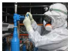
原子炉補機冷却水系加圧操作 (周辺補機棟 T. P. 43. 6m)
