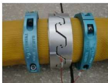
可搬型ホース(150A)接続後
