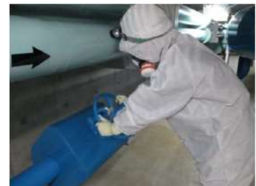
通水操作 (周辺補機棟 T.P. 2.3m)
