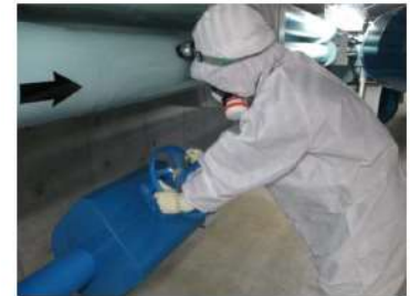
通水操作 (周辺補機棟 T.P. 2.3m)
