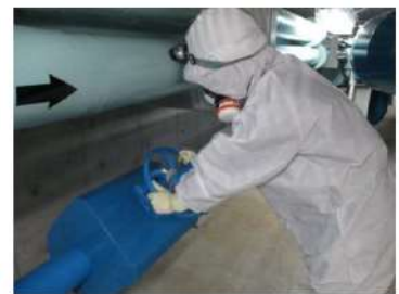
通水操作 (周辺補機棟 T. P. 2. 3m)
