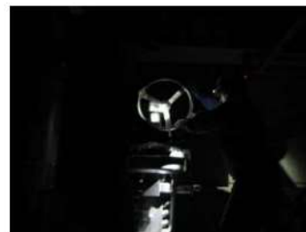
主蒸気逃がし弁開放操作(照明消灯時) (周辺補機棟 T.P.33.1m)
