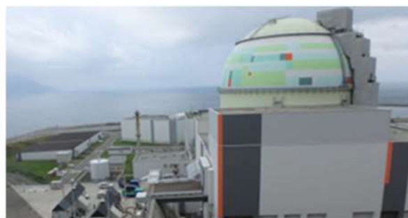
3号炉北東法面
