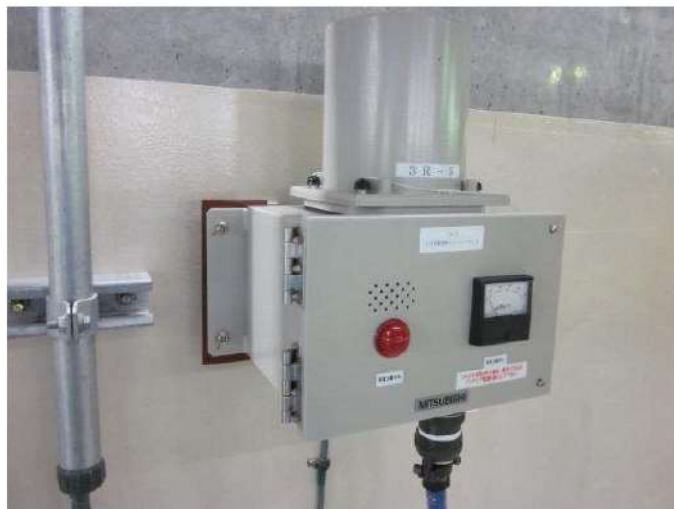
図2 機器のボルトによる壁面固定
