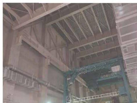
図 5.2.2 燃料取扱棟の屋根
