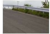
ガードレール
