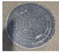
マンホール蓋
