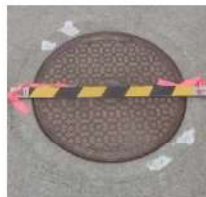
マンホール蓋
