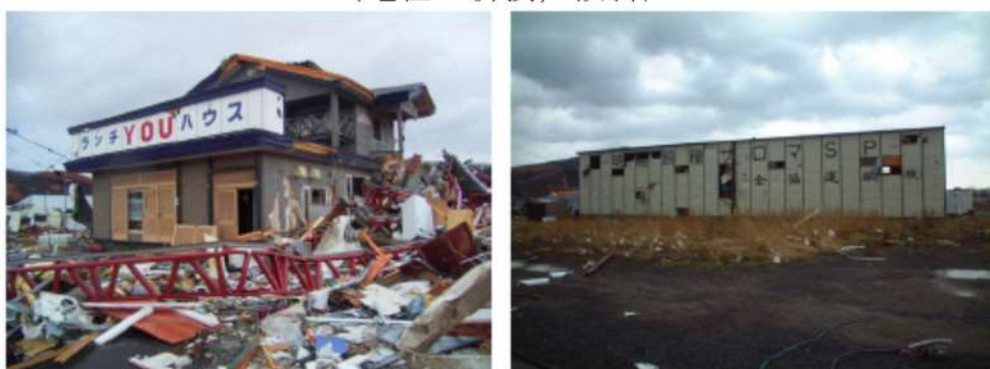
(建築物への飛来物の衝突痕)
