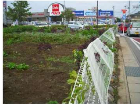
フェンスの変形
