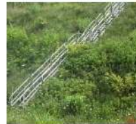
階段（単管パイプ製）
