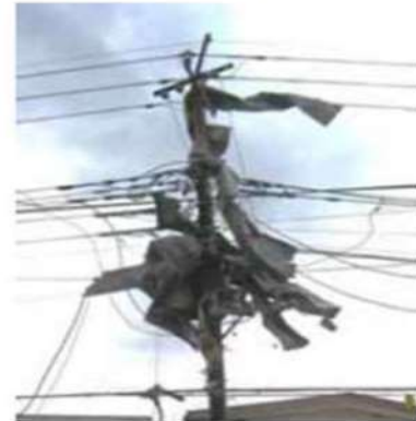
飛散した折板屋根の状況
