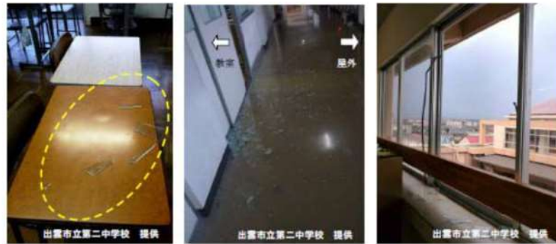
(1) 教室 (2) 廊下 (3) 屋外に面した窓ガラス
