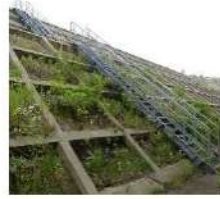
階段（H鋼製）
