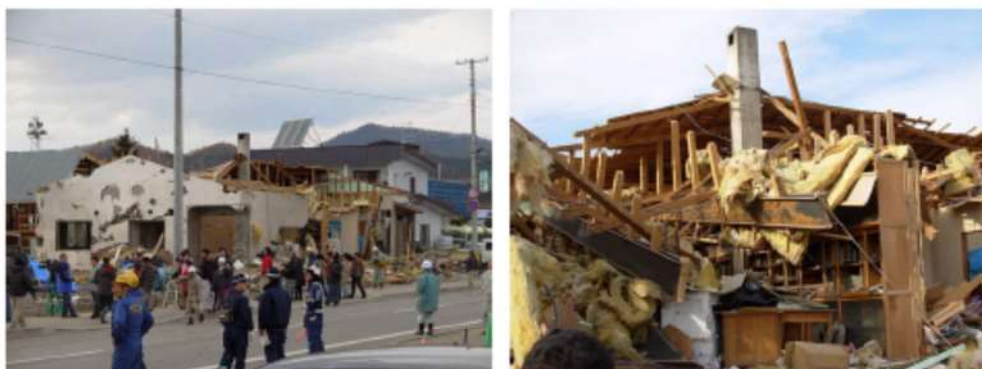
(電柱の折損，傾斜)
