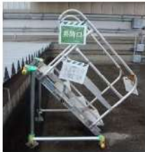
階段（単管パイプ製）
