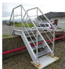
階段（H鋼製）
