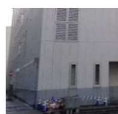
外壁 (セメント板)
