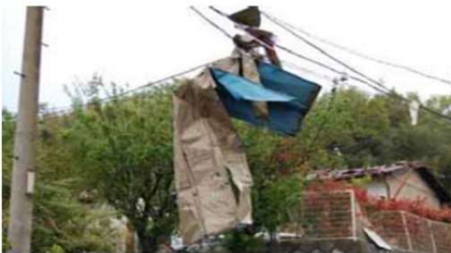
電線等に引っ掛かった飛来物（鋼板製屋根材）
