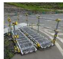
階段（単管パイプ製）
