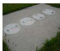
マンホール蓋
