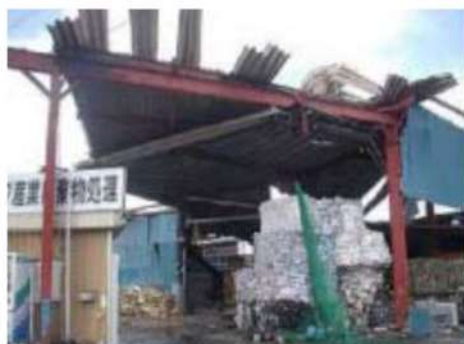
折板の損傷
