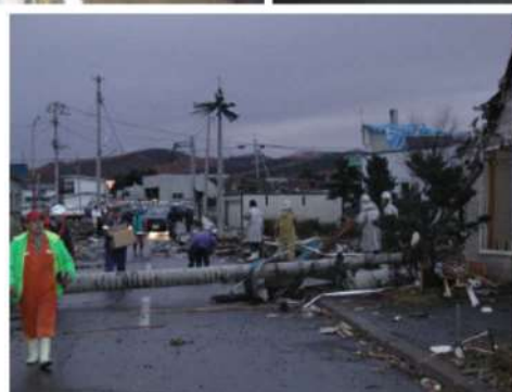
(電柱，道路標識の折損)
