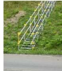
階段（単管パイプ製）
