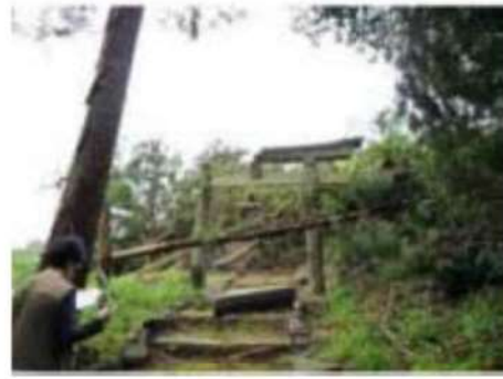
倒木の折損と鳥居の被害
