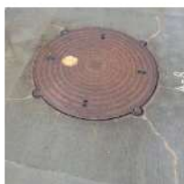
マンホール蓋
