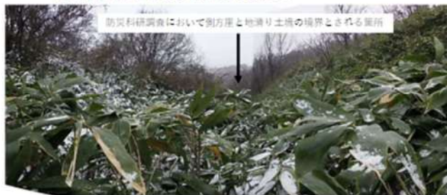
P2 防災科研調査において側方崖と地滑り土塊の境界とされる箇所 の状況。沢を挟んだ両岸において、斜面の角度が同程度となっており、側方崖を示唆する特徴である。地滑り土塊とされる箇所に向かう明瞭な急傾斜は認められない。
