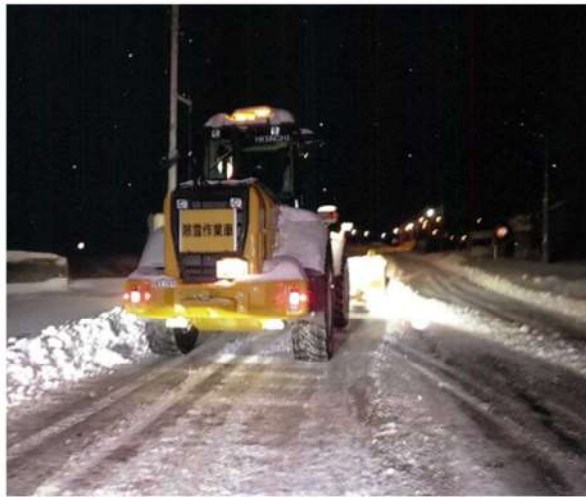
第4-2図 重機による除雪作業（2）
