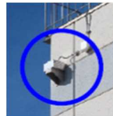
常設型加速度計(建屋)
