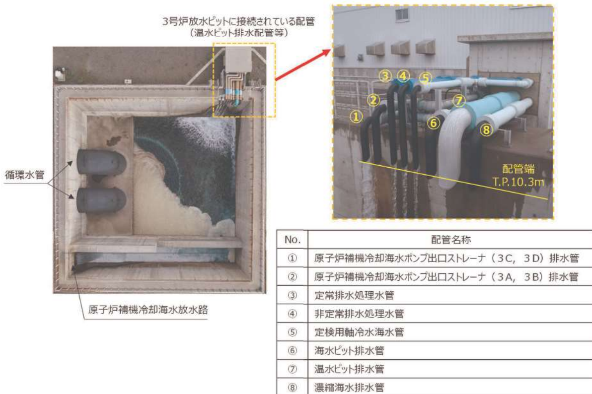
第 2.2-15 図 3号炉放水ピットに接続されている排水管
