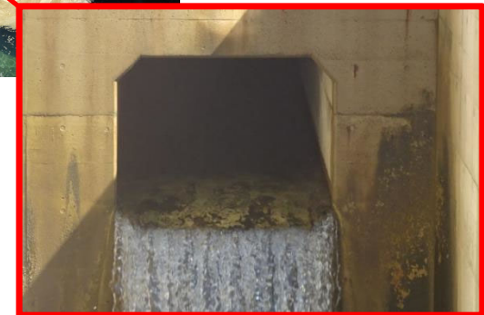
3号炉原子炉補機冷却海水放水路の状況
