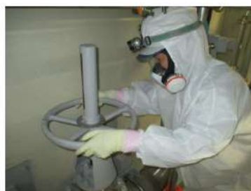
燃料取替用水ピット 水源切替系統構成 (周辺補機棟 T.P. 17.8m)
