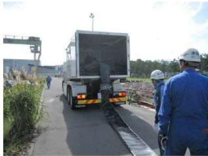
ホース延長・回収車 (放水砲用) による可搬型ホース敷設 (屋外)
