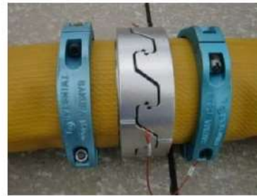
可搬型ホース (150A) 接続後
