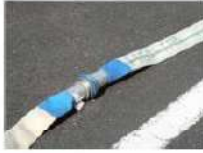
④ 可搬型ホース接続後
