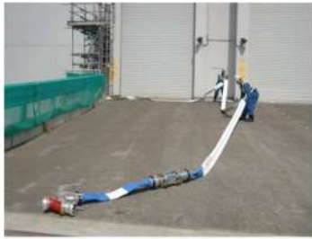
可搬型ホース敷設 (屋外)
