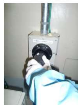
電源ケーブル接続
