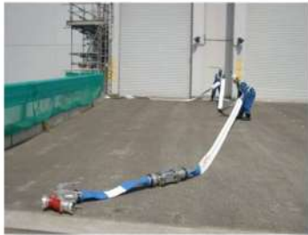
可搬型ホース敷設 （屋外）
