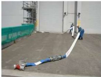
可搬型ホース敷設 （屋外）
