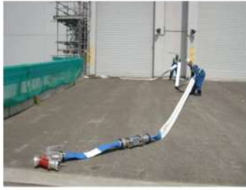
可搬型ホース敷設 (屋外)
