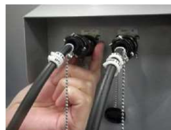
検出器用ケーブル接続
