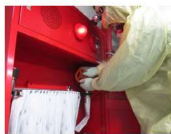
消火ポンプによる注水 (燃料取扱棟 T.P. 33. 1m)
