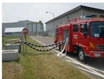
可搬型大型送水ポンプ車の設置 原水槽への吸管挿入 (屋外)
