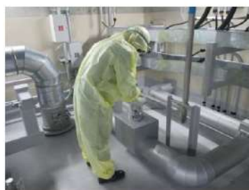
可搬型大型送水ポンプ車による 原子炉容器への注水 系統構成 (運転員 (現場) B) (原子炉補助建屋 T.P. 10.3m (中間床))
