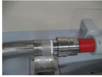
消火水系配管と 格納容器スプレイ系配管との 接続のための可搬型ホース配管接続後 (運転員(現場) B) (原子炉補助建屋 T. P. 10. 3m)
