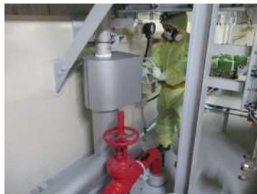
可搬型大型送水ポンプ車による 原子炉容器への注水 系統構成 (運転員 (現場) B) (原子炉補助建屋 T.P. 10.3m)
