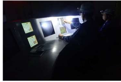
シミュレータ施設で可搬型照明（ヘッドライト）を複数人で使用した状態
