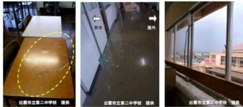
(1) 教室 (2) 廊下 (3) 屋外に面した窓ガラス
