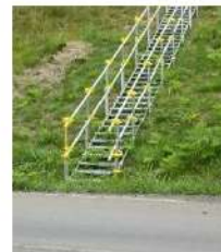
階段（単管パイプ製）
