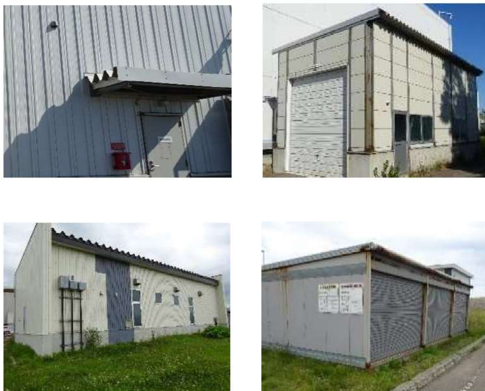
図18 泊発電所における屋外屋根の状況
