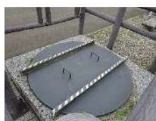
マンホール蓋
