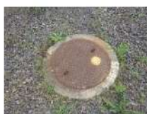
マンホール蓋
