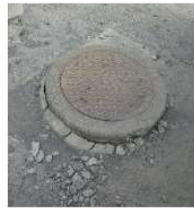
マンホール蓋
