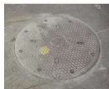
マンホール蓋
