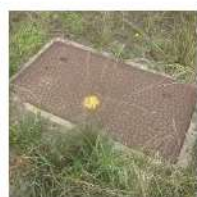
マンホール蓋
