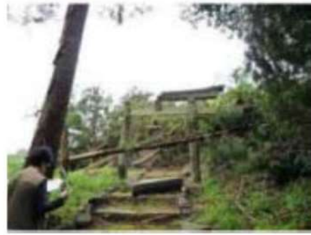
倒木の折損と鳥居の被害
