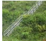
階段（単管パイプ製）
