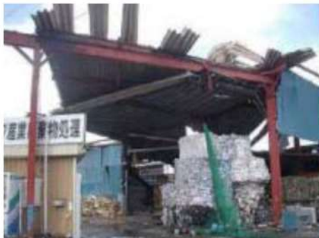
折板の損傷
