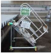
階段（単管パイプ製）
