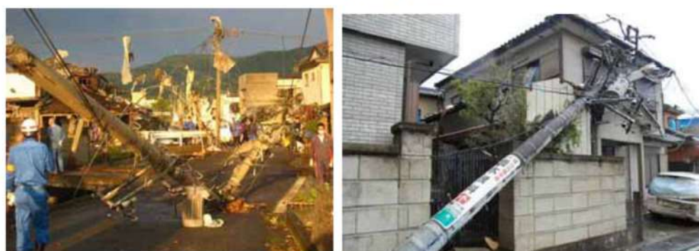
(電柱の折損, 傾斜)
