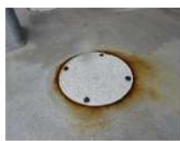
マンホール蓋
