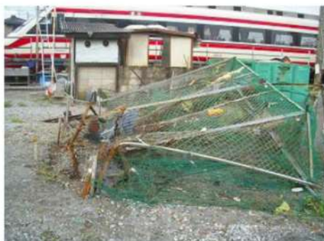
フェンスの著しい変形
