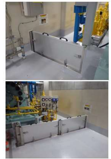
図5-4 止水板設置状況
