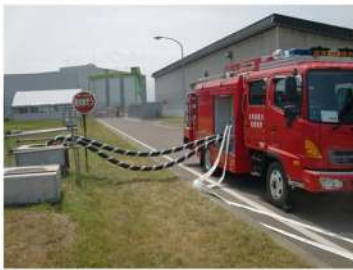
可搬型大型送水ポンプ車の設置 代替給水ピットへの吸管挿入 （屋外 T. P. 33. 1m） （作業風景は類似作業）
