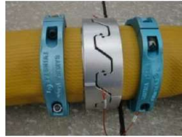
可搬型ホース（150A）接続後
