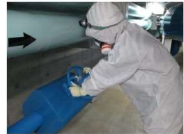
通水操作 (周辺補機棟 T.P. 2.3m)
