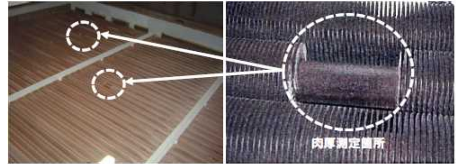
③の例：主冷却器伝熱管の肉厚確認結果
