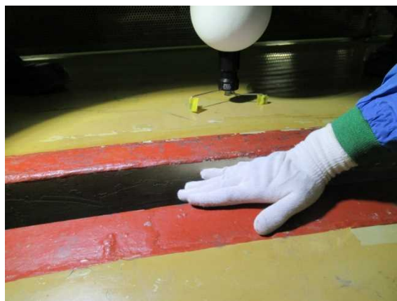
図 20 東端と DSP 側床面 (右図の左端) との間の状況 (敦賀 1 号機シールドプラグ) 10
