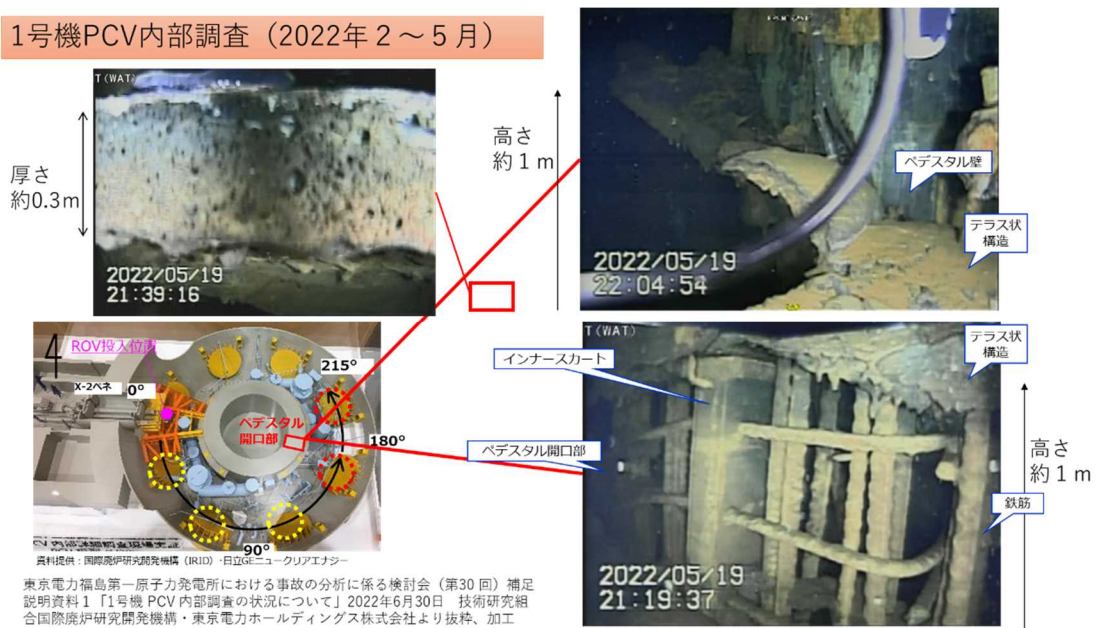
図4 1号機PCV内部調査②
