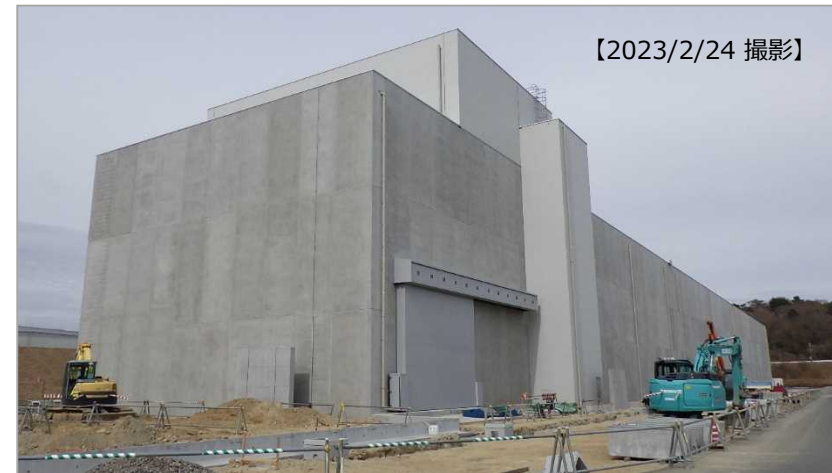
【現場状況：南面・東面】
