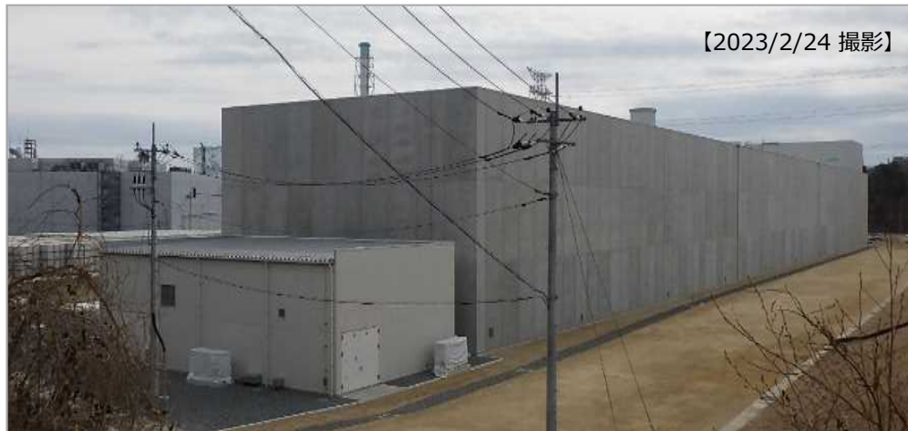
【現場状況：北面・西面】
