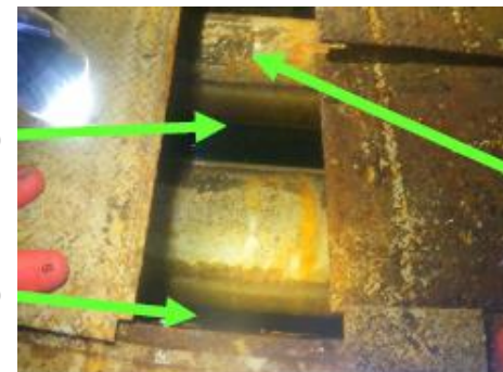
採取箇所現場状況 (カメラB)
