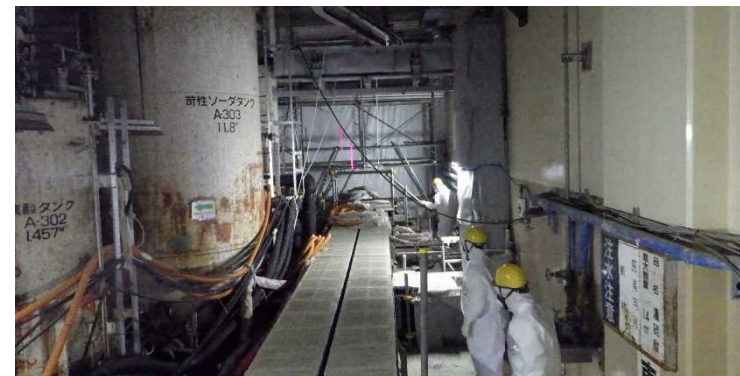
建屋北西付近（ゼオライト保管容器搬出入箇所）
