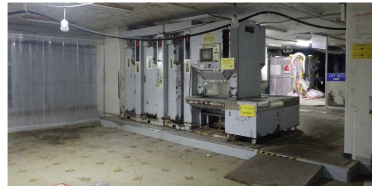
補機設置予定エリア付近
