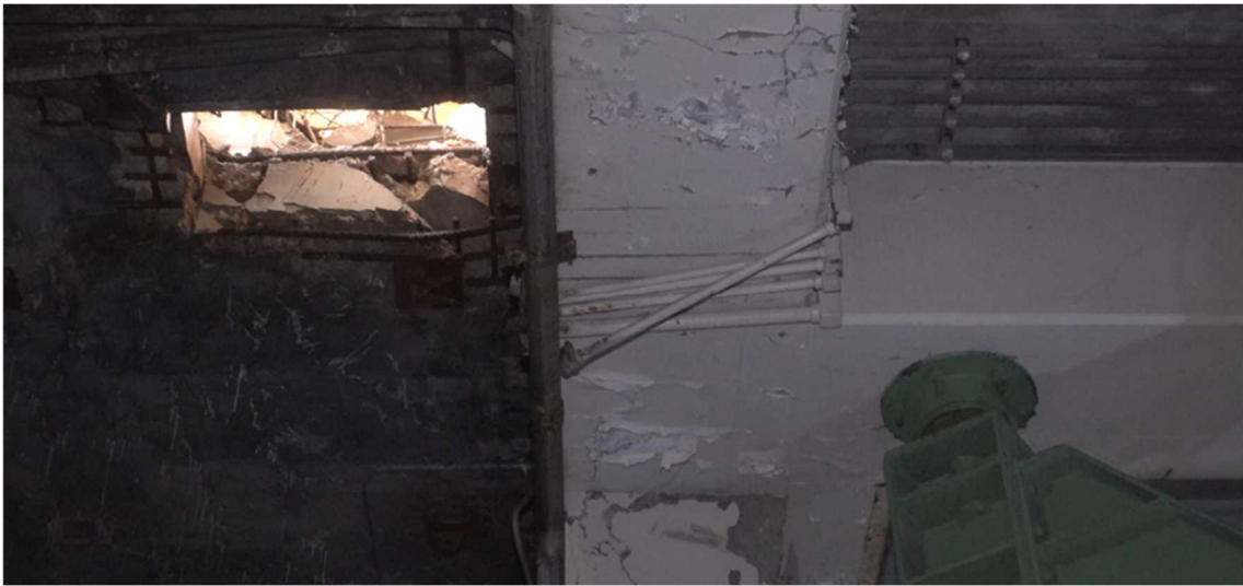
図 45 IC の南側付近の天井（1号機原子炉建屋4階）
