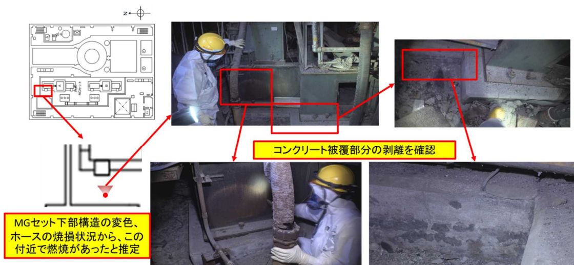
図11 MGセットの西側（下部構造及びコンクリート基礎）の状況
