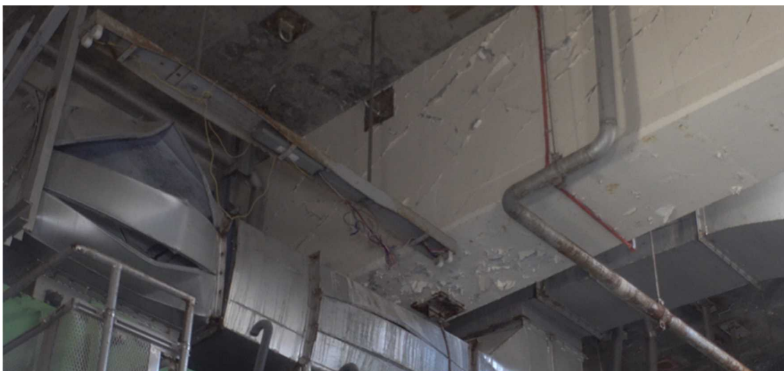
図 36 天井付近のダクト及び梁
