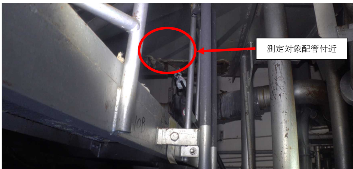
図 14 測定対象配管周辺の状況
