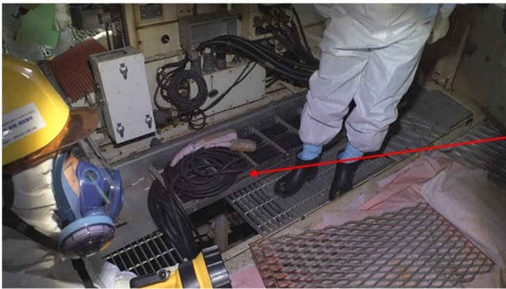
図 17 原子炉圧力容器下部（複合ケーブル（PIP ケーブル）等）の設置状況 (2)
