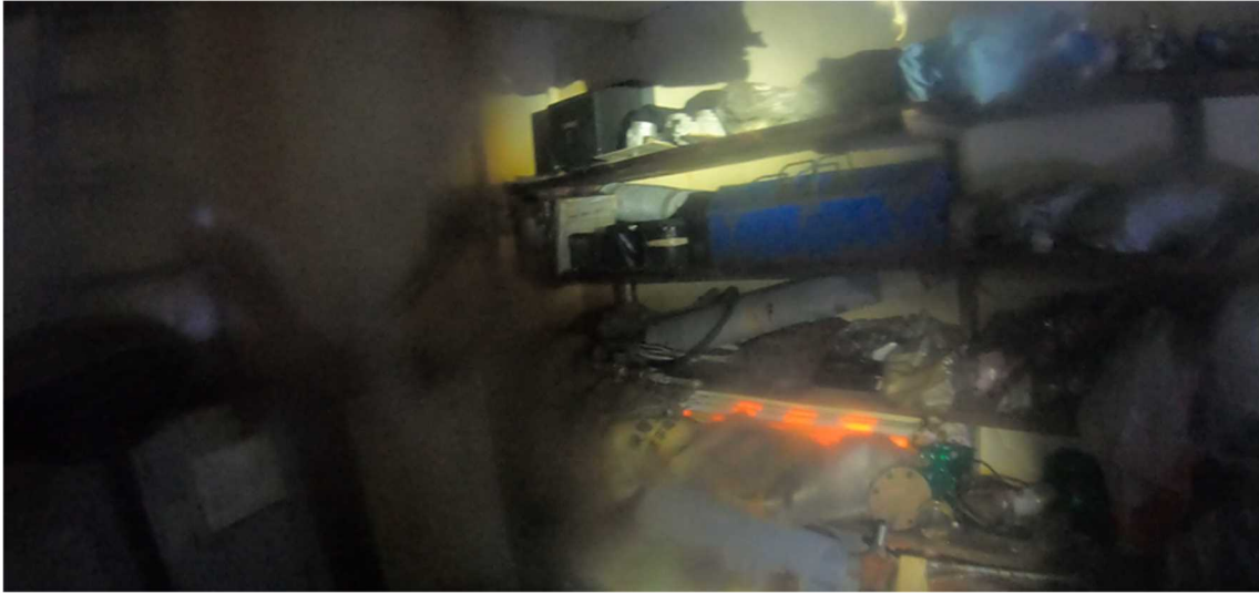
図8 1号機原子炉建屋3階東側の部屋（CRD リペア室）の状況 （部屋内部の資機材の状況）
