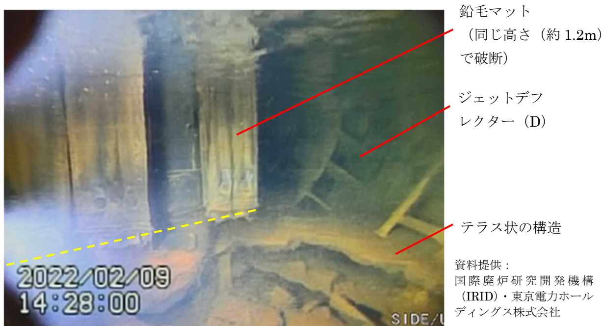
図5 ペDESTAL外周部（開口部付近）
