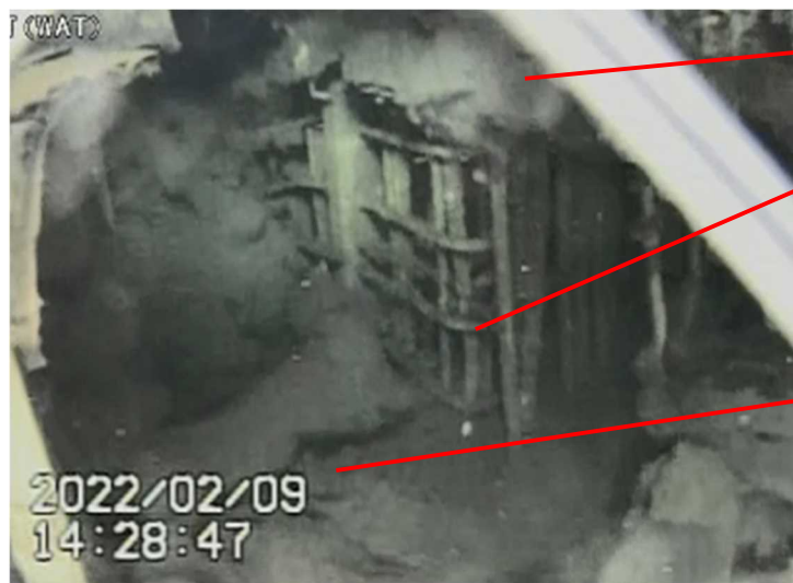
図8 1号機ペDESTAL開口部付近
