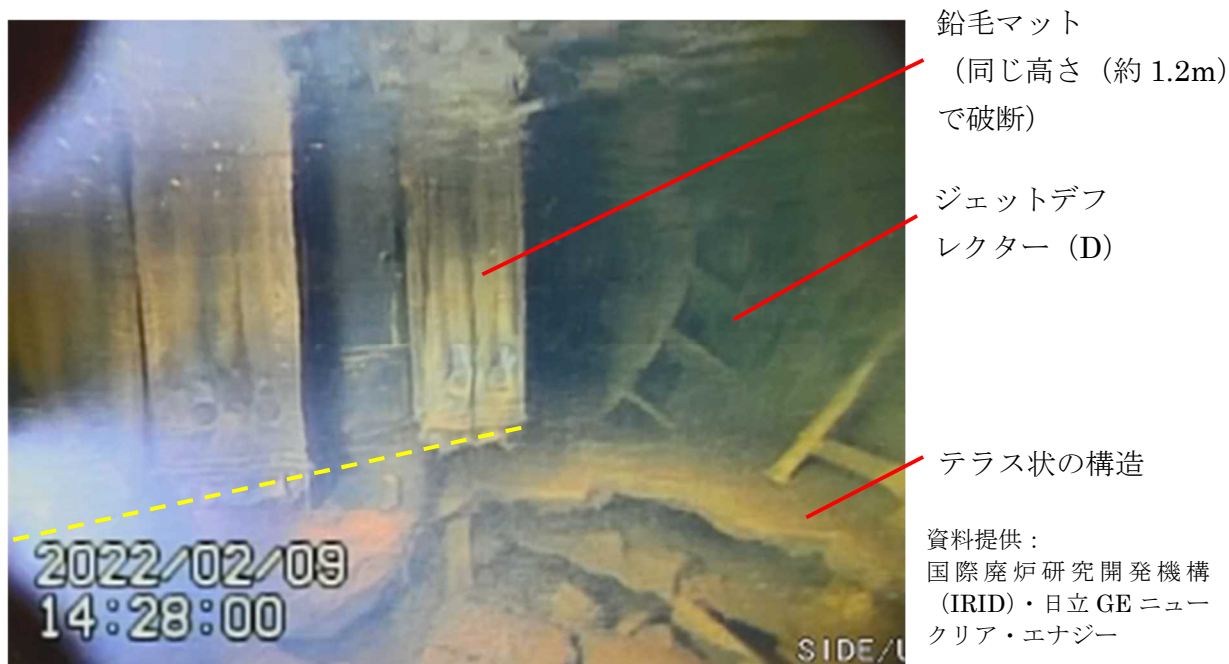
図5 ペDESTAL外周部（開口部付近）
