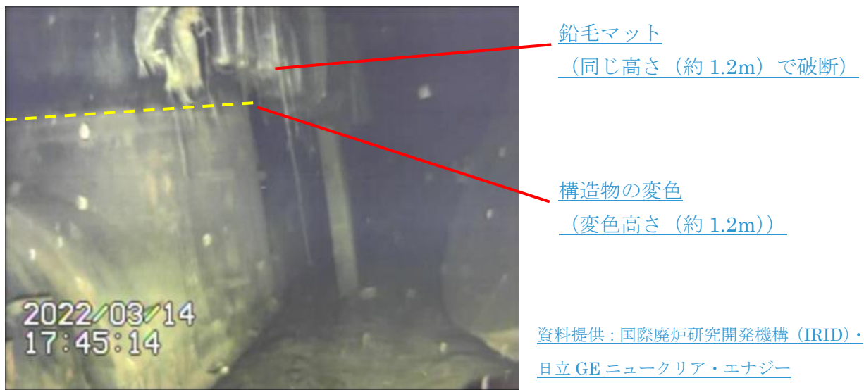
図10 1号機ペDESTAL外周部（開口部反対側付近）
