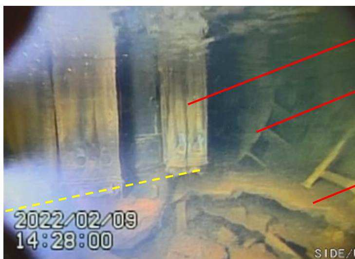
図7-9 1号機ペDESTAL外周部(開口部付近)
